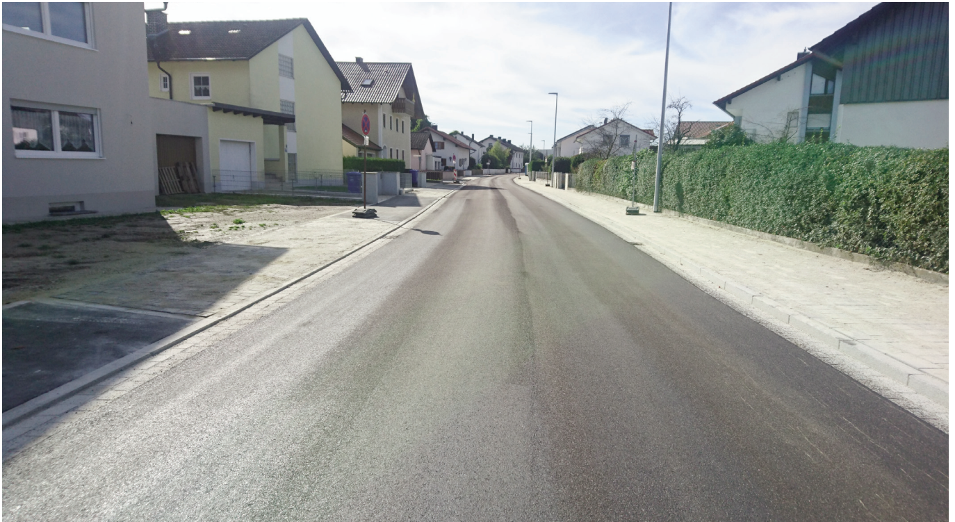
Geratsberger Straße – Bauarbeiten planmäßig abgeschlossen
