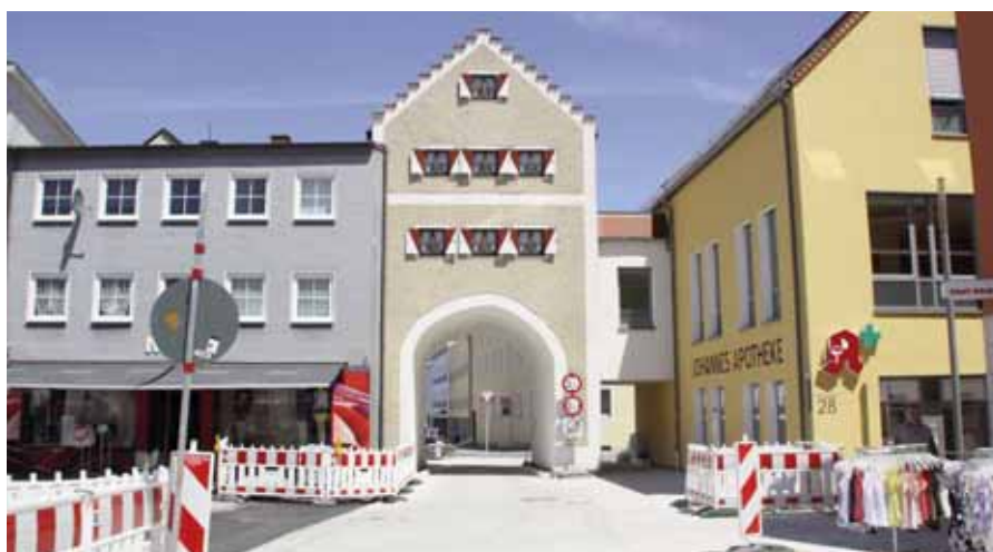
Das Wollertor – seit Juni wieder für den Verkehr freigegeben
